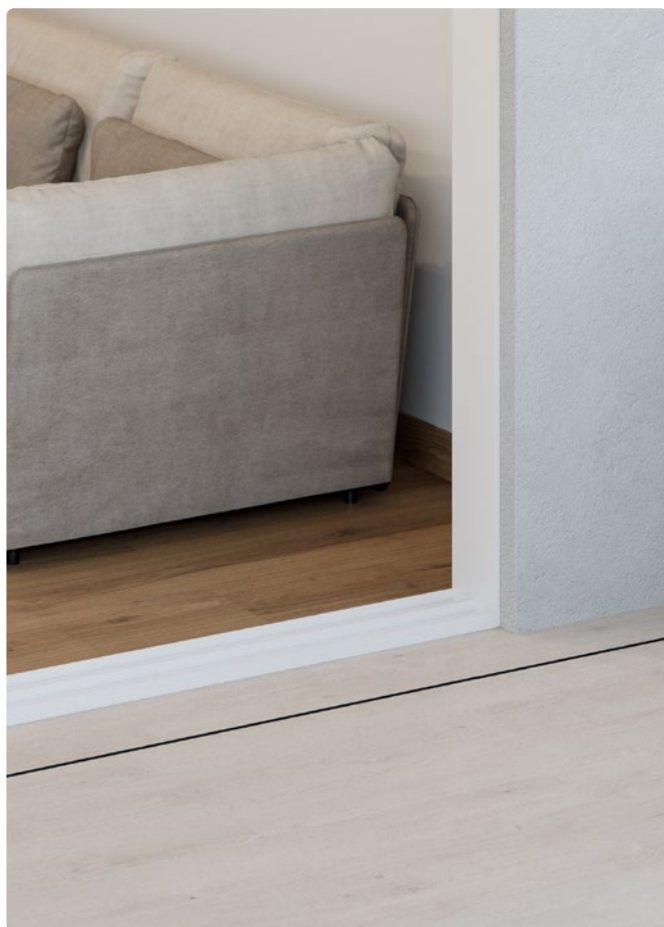
A fessura singola
