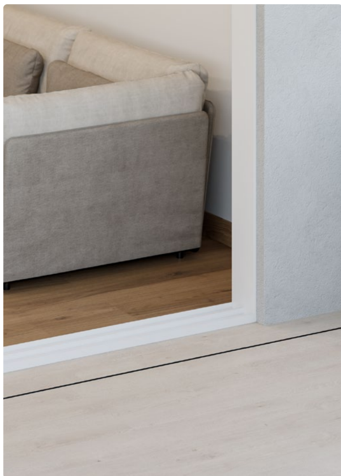
A fessura singola
